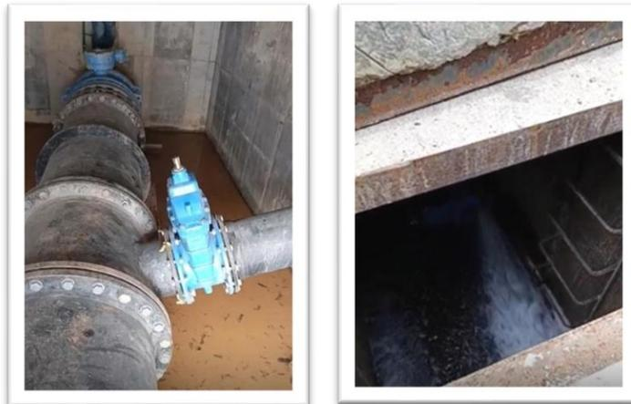
Fotografías No. 7 y 8. Lavado de tubería proyecto PDA, fotografía 7 válvulas tanque concreto PTAP, fotografía 8 Válvula de purga.
