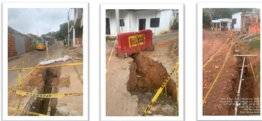
Fotografía No. 3, 4 y 5 . Instalación de línea de impulsión tanque Morichal
