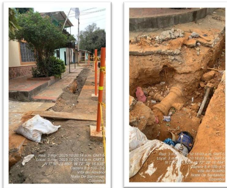
Fotografía No. 1 y 2 . Reposición de tubería PVC Ø 8” Acueducto carrera 8 calles 1N hasta la 3
